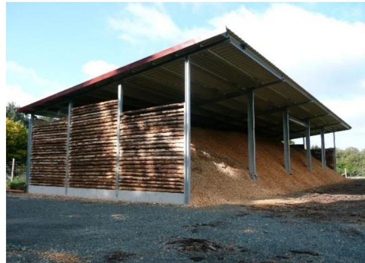
Lagerhalle mit Aufbereitungsplatz für Energieholz im Außenbereich
